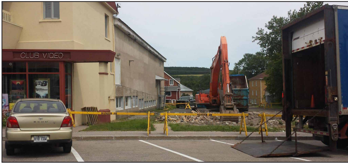
Démolition de la maison du cordonnier à La Malbaie
